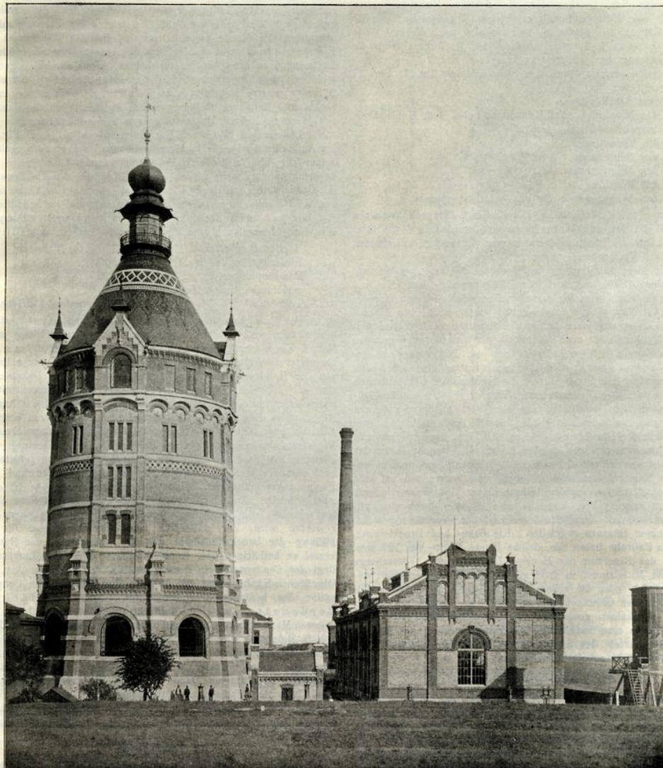
Fig. 1. Ansicht des Wasserturmes und Maschinenhauses.
